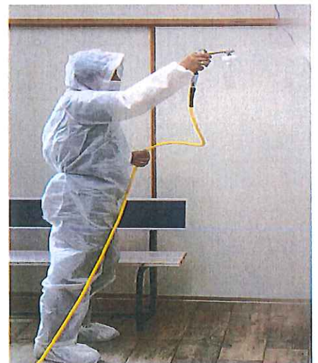
完全衛生管理施工
